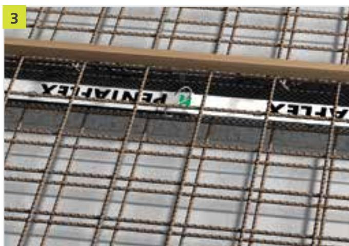
Polaganje gorenje armature i postavljanje gornje oplate za betoniranje. ABS element pričvrstiti za gornju armaturu s pomoću žice za vezanje armature. Može se odabratи i mogućnost spajanja elementa s armaturom zavarivanjem. Prije betoniranja 2. segmenta skinuti zaštitnu foliju s gornje i donje strane perforiranog lima!
