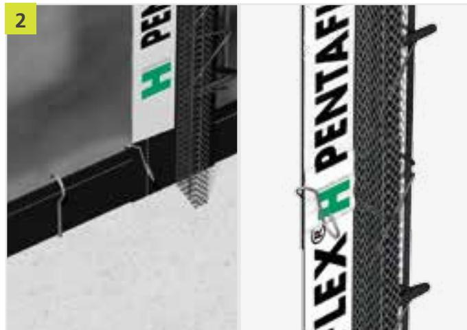
Spojevi se moraju preklapati 50 mm. Pri temperaturama nižim od +5 °C mjesto spoja mora se zagrijati. Spoj osigurati križnom kopčom.
