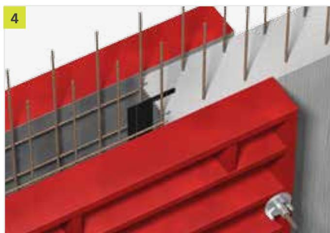
Prije oplaćivanja drugog segmenta za betoniranje ukloniti preostalu zaštitnu foliju s PENTAFLEX KB®, građevni element armirati i zatvoriti oplatu.
