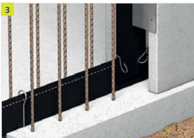
Brtveni lim s okomitim zaštitnim slojem spojiti s PENTAFLEX KB® u podnoj ploči. Spajanje se vrši putem preklapanja od najmanje 50 mm čvrstim pritiskom jednog na drugi. Svako mjesto spajanja mora se osigurati pomoću dvije križne kopče. Kod temperatura ispod +5 °C površina spojeva mora se zagrijati.
