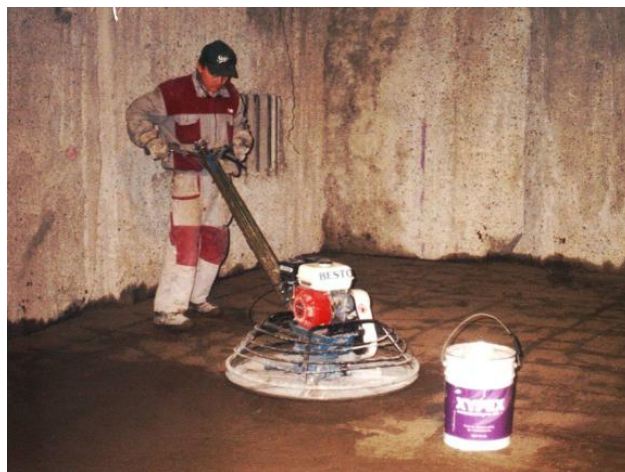
Ugradba materijala XYPEX® Concentrate DS-1 u površinu betona
